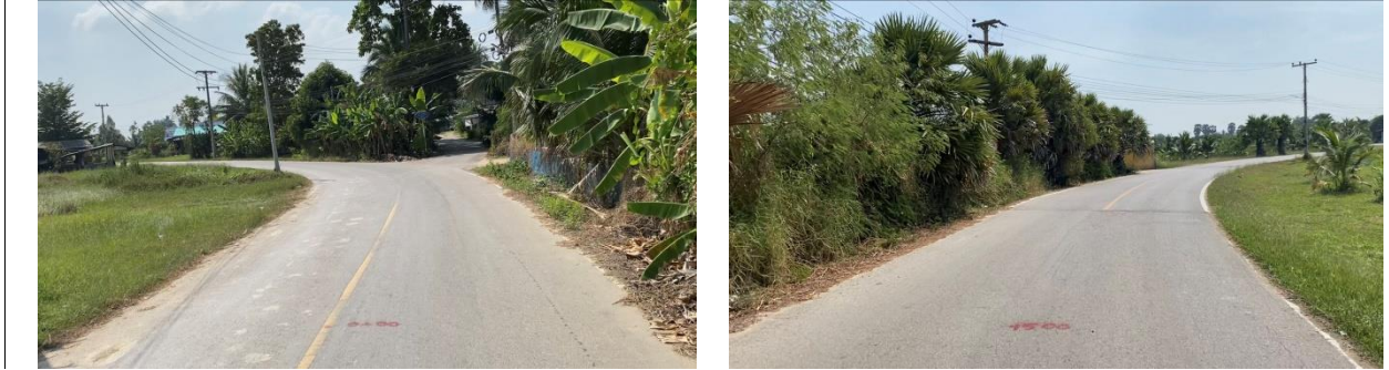
ภาพก่อนดำเนินการ
